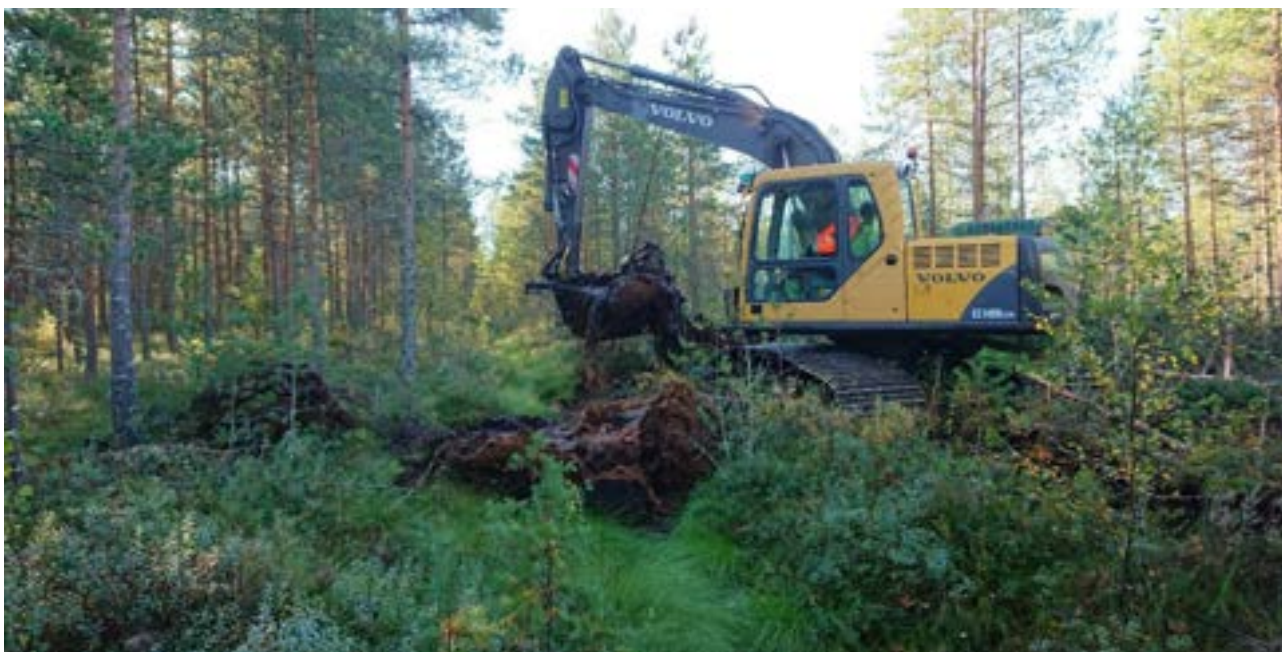
Kuva 7. Soiden ennallistamisen päätyö on ojien tukkiminen kaivinkoneella. Seinäjoki, Sahanneva 2022.
