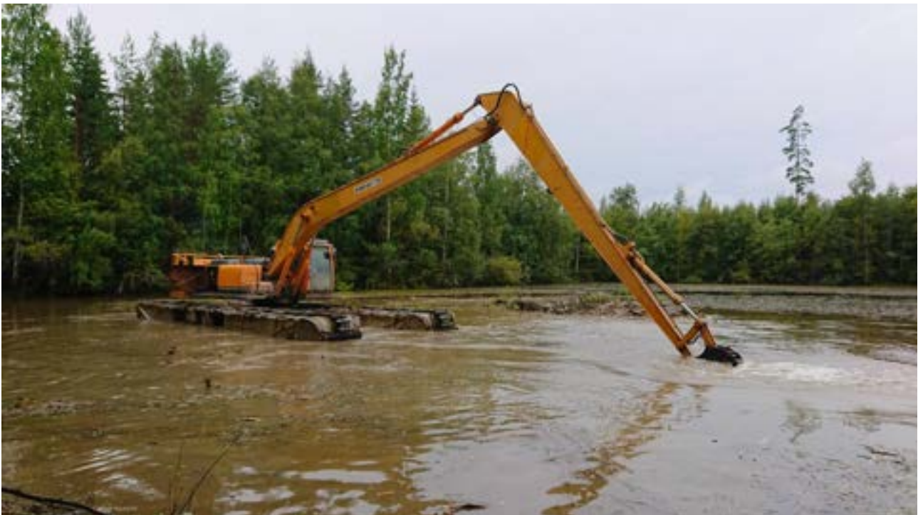
Kuva 42. Syvänteiden, matalikkojen ja niemekkeiden ruoppausta kelluvalla kaivinkoneella Keuruun Ristakosken altailla 2022.
