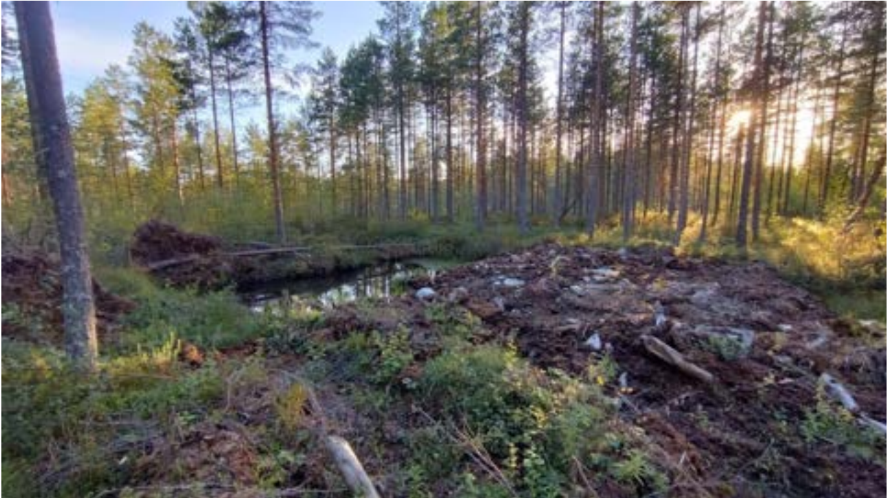
Kuva 8. Esimerkki kaivinkoneella tehdystä padosta. Paikalla virtasi oja vasemmalta oikealle. Patomaat on otettu padon vasemmalta puolelta, johon muodostui lampare. Seinäjoki, Sahanneva 2023.
