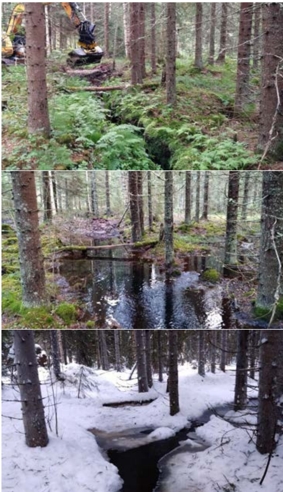
Kuvat 30-32. Puron virtaaman palauttaminen vähäksi matkaa vanhaan uomaan Keuruun Tervaspurossa. Virtaus kohti kuvaajaa. Vanha uoma lähtee kaivinkoneen tekemän padon takaa ja palaa ojaan oikealta. Seuraava pato on nostanut veden korkealle myös ojassa. Kuvat patoamisesta 29.7.2024 sekä 9.11.2024 ja 23.12.2024.
