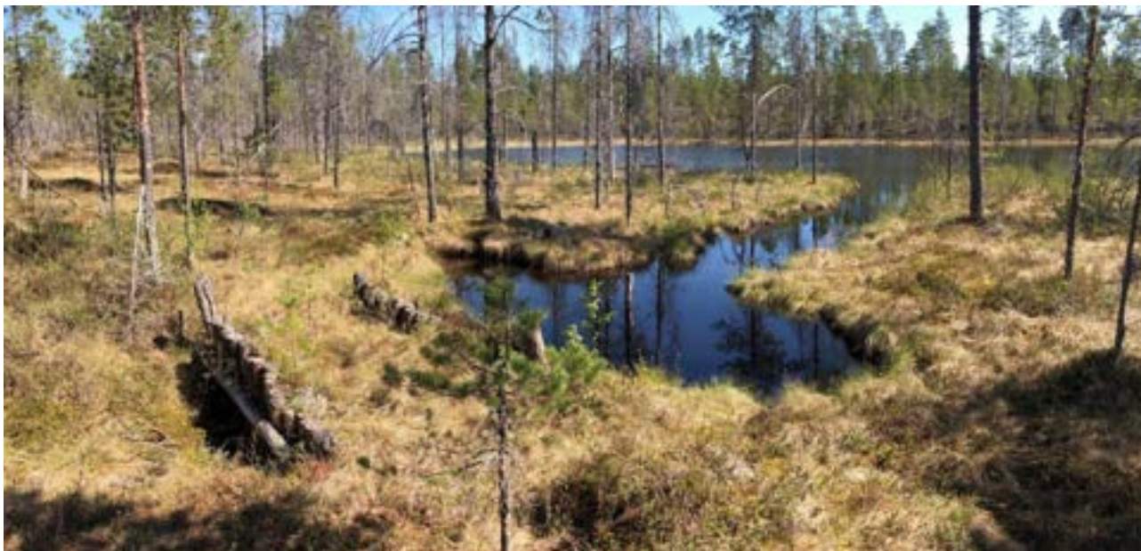
Kuva 6. Lammen ojittamalla lasketun vedenpinnan nostokin voi onnistua käsityönä puu-turvepadolla. Vuonna 2016 tehty pato kuvattuna 2024. Lammen vedet laskevat nyt kuvan oikean alakulman kautta suon läpi. Multia, Köpinneva. (kuva: Tuomas Kirjavainen)
