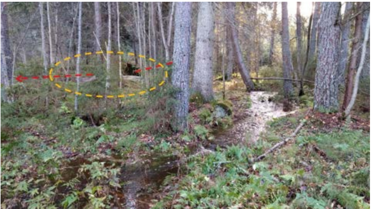
Kuva 27. Ojan virtaama käännettiin alkuperäiseen purouomaan Jyväskylän Laajavuoressa 2023. Virtaaman kääntävä pato näkyy keltaisessa ympyrässä ja ojan sijainti on havainnollistettu punaisella nuolella.
