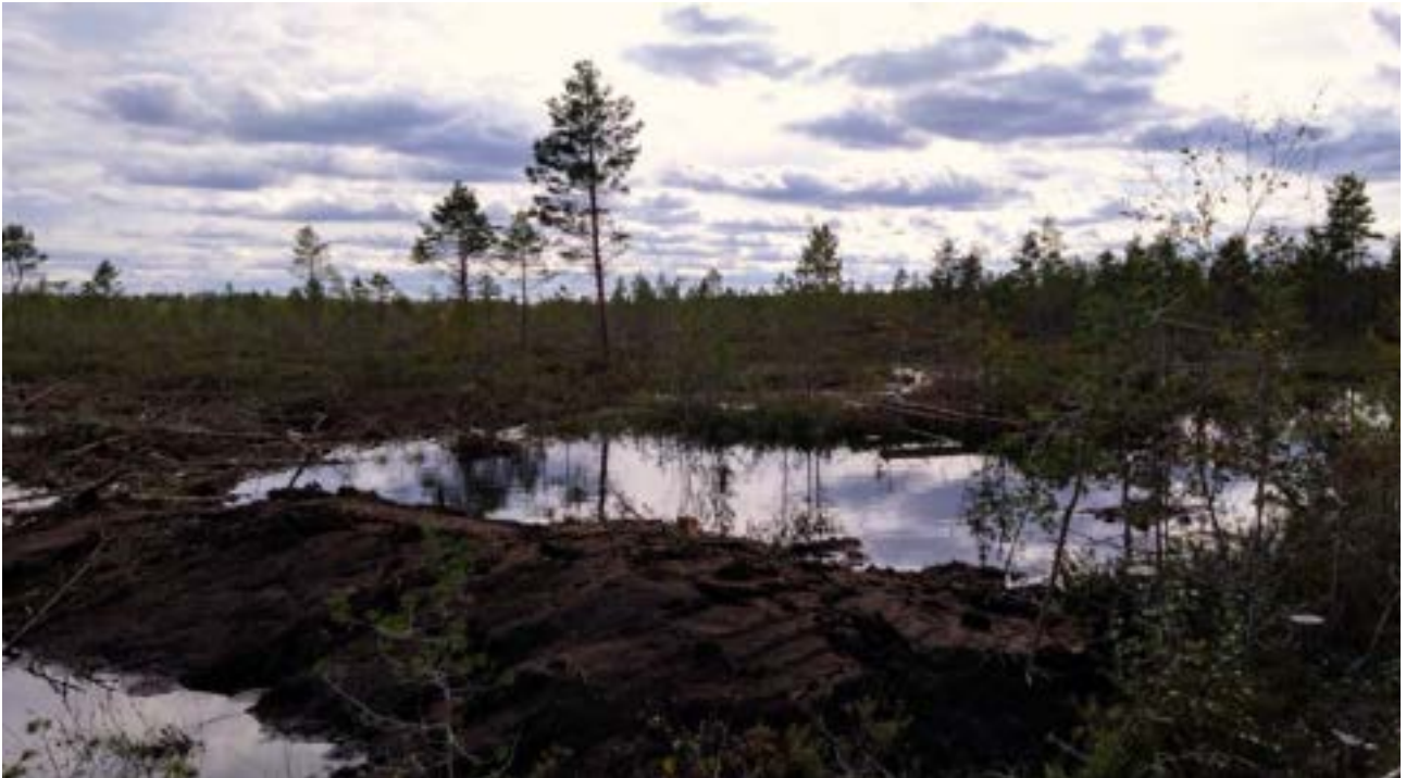
Kuvat 20 ja 21. Ennallistamistyöt Seinäjoen Sahannevalla 15.8.2023 ja sama pato 7.9.2023. Taustalla aukko, josta on poistettu yksipuolinen ojituksen jälkeen kasvanut mäntypuusto avosuon palauttamiseksi.
