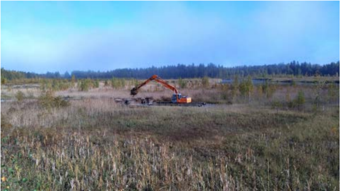
Kuva 36. Kelluva kaivinkone ruoppaamassa avovesiuomia Mänttä-Vilppulan Käkijärvellä 2023.
