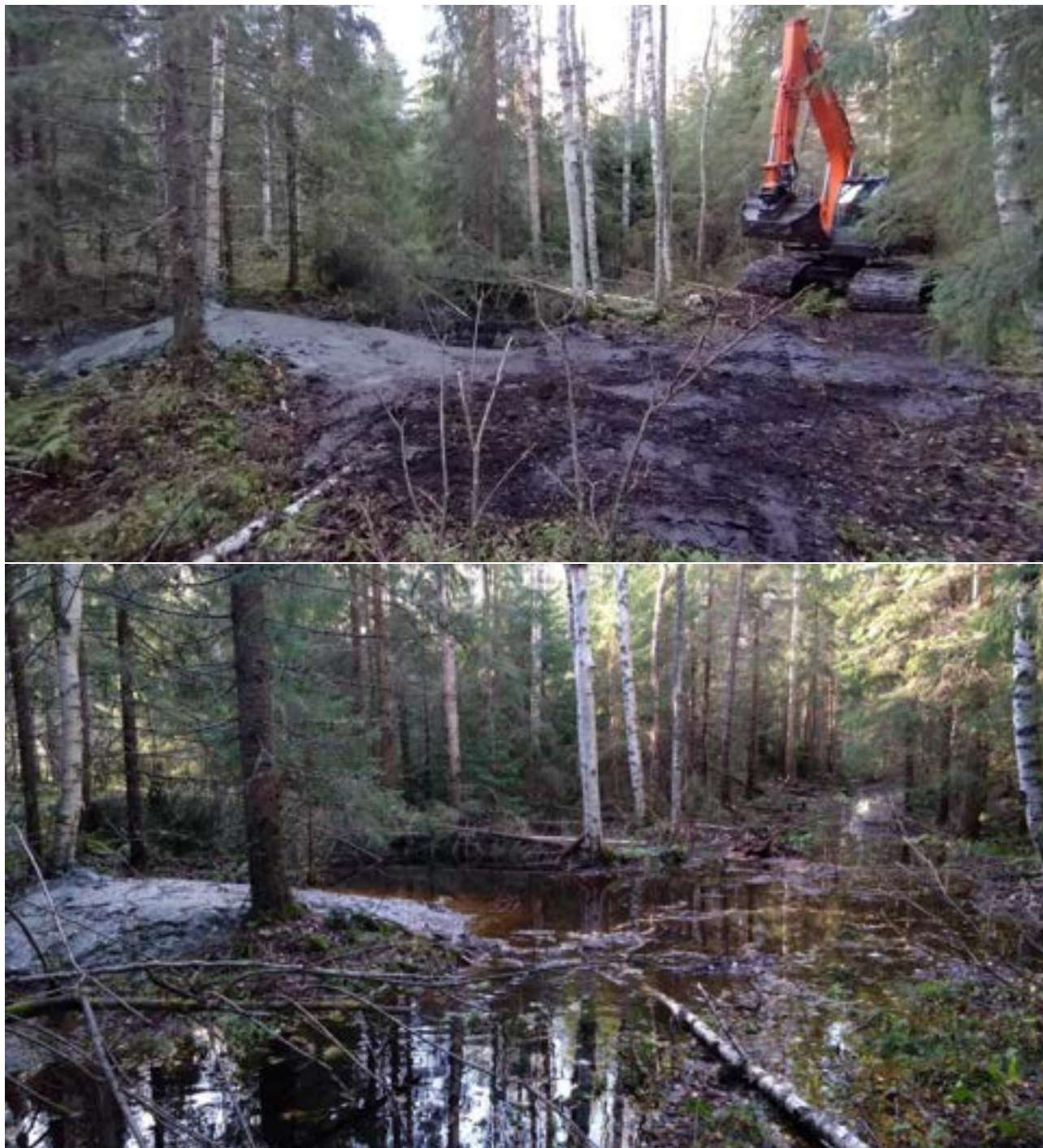
Kuvat 18 ja 19. Kun ojassa virtaa näkyvästi vettä, patoaminen nostaa vedenpinnan jo muutamassa päivässä. Kuvat Jyväskylän Lammakesuolta työn aikaan 6.10.2023 ja 12.10.2023.
