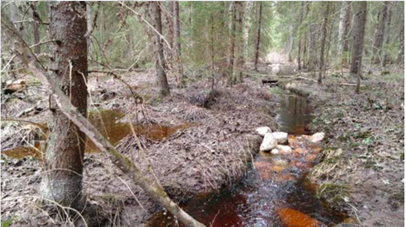
Kuvat 28 ja 29. Keuruun Heinäsuolla puron virtaamaa hidastettiin ja monipuolistettiin kiveämällä.
