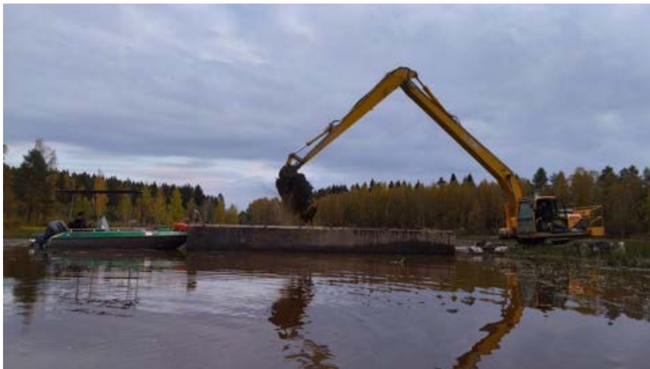
Kuva 34. Ruoppaus kelluvalla kaivinkoneella ja massojen kuljetus proomulla on vartenotettava vaihtoehto lintuvesikunnostuksissa. Keuruu, Kaivoslahti 2023.
