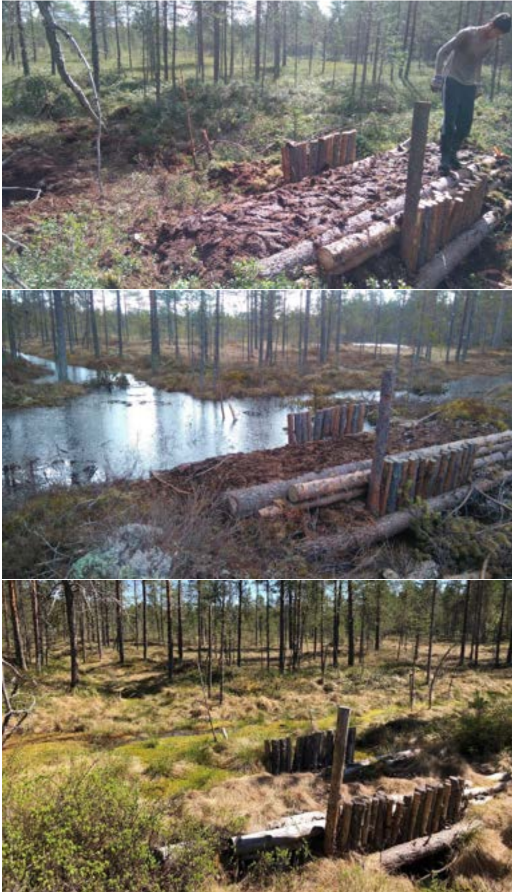
Kuvat 3-5. Käsityönä tehty pato rakennusvaiheessa syksyllä 2016, ensimmäisenä keväänä 2016 sekä alkukesällä 2024. Multia, Köpinneva. (alin kuva: Tuomas Kirjavainen)
